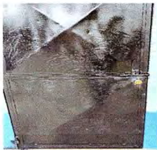
Foto 5: APLICACIÓN DE MANTENIMIENTO A ESTRUCTURA DE PUERTAS DE METAL (LIJADO, CAMBIO DE TUBO, CEPILLADO Y APLICACIÓN DE PINTURA.)
