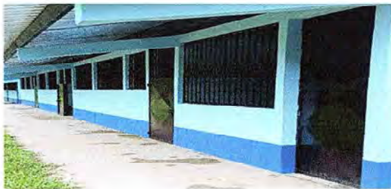
Foto 3: Aplicación de mantenimiento de pintura de los edificios del establecimiento.
