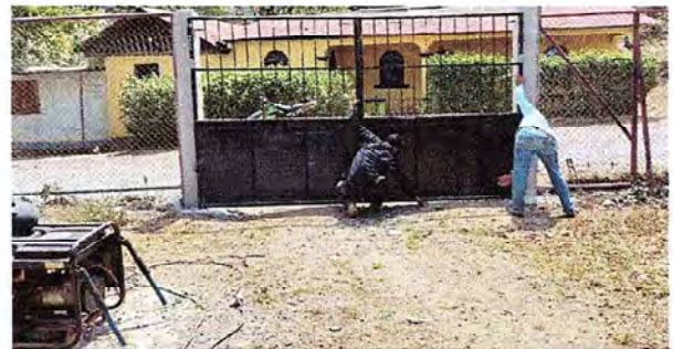
Foto 4: Instalacion de Porton DE METAL
