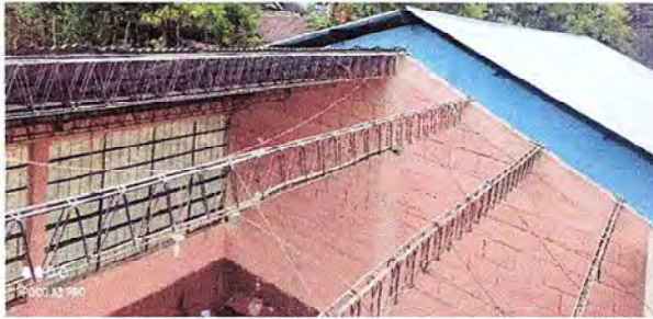
Foto1: Instalando costaneras del edificio No. 1
